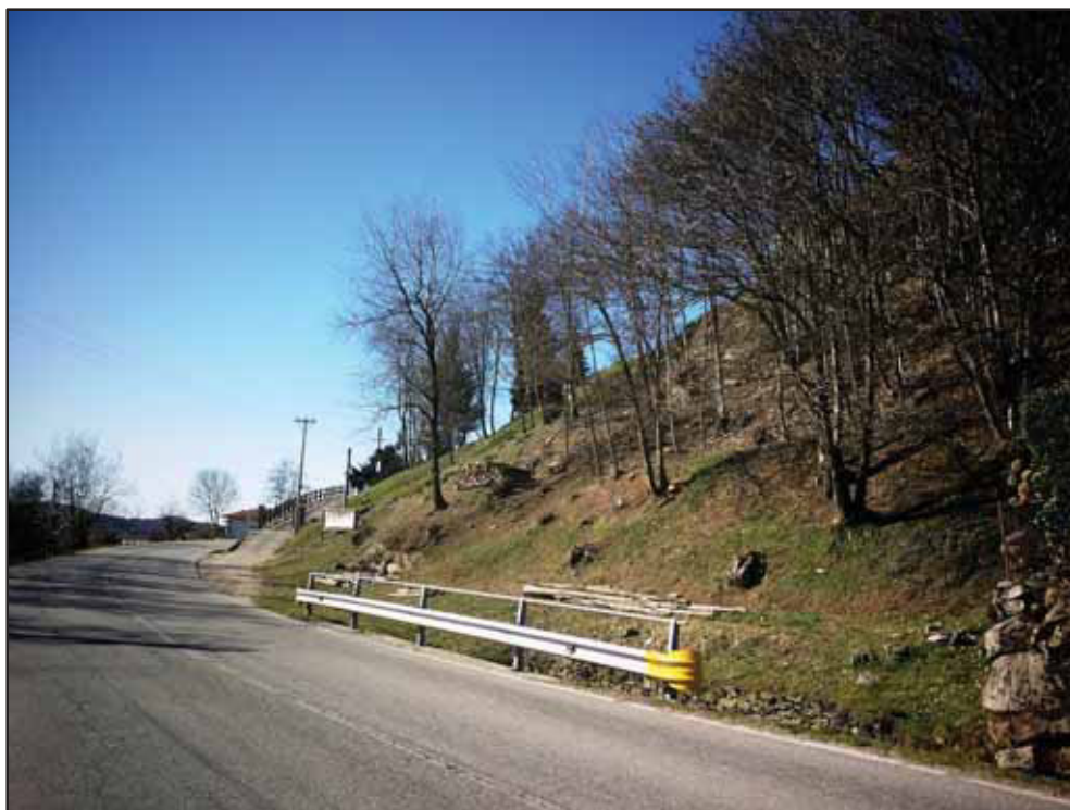
Figura 9 - Ripido versante permeabile lungo la SP34 dell'Alto Versante (Massino Visconti), nella porzione sudorientale del varco V02-Massino Visconti/Nebbiuno.
