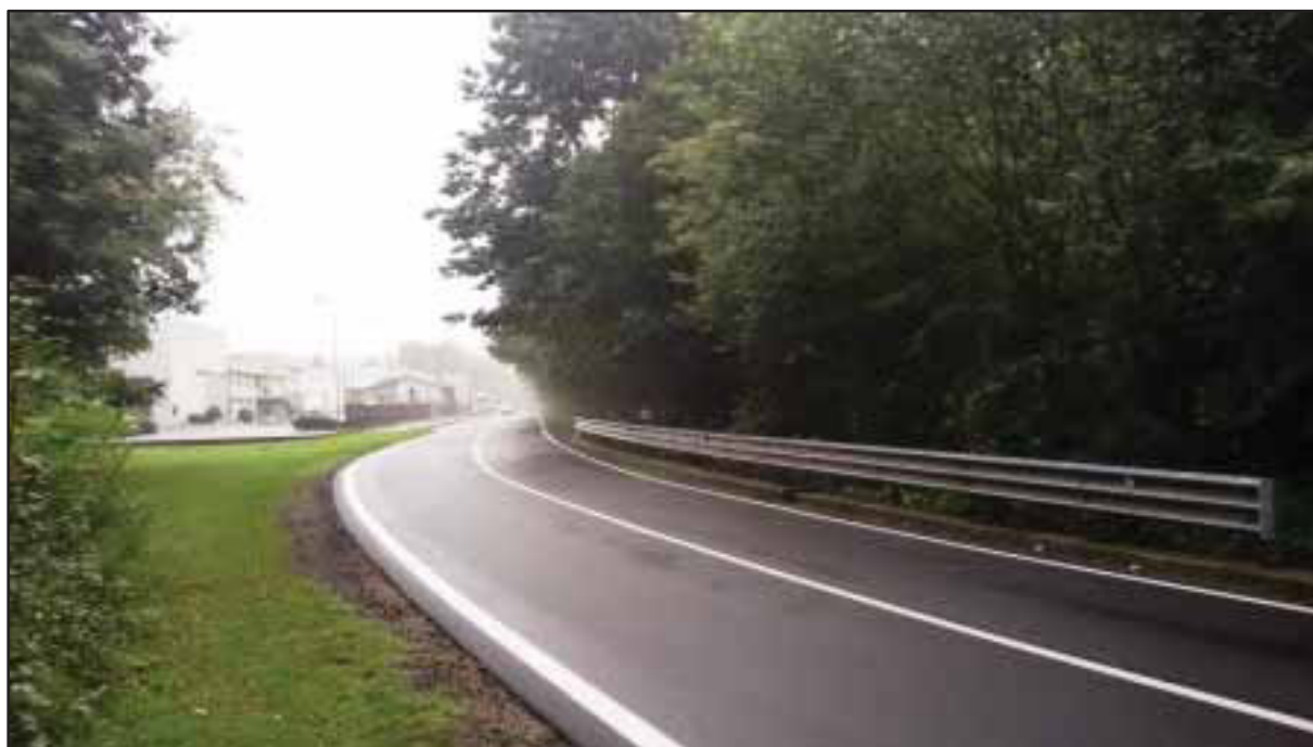
Figura 103 – Tratto settentrionale della SP33/A di Briga che attraversa le formazioni boschive presenti nella porzione iniziale del Corridoio C2 (ramo C2b).
