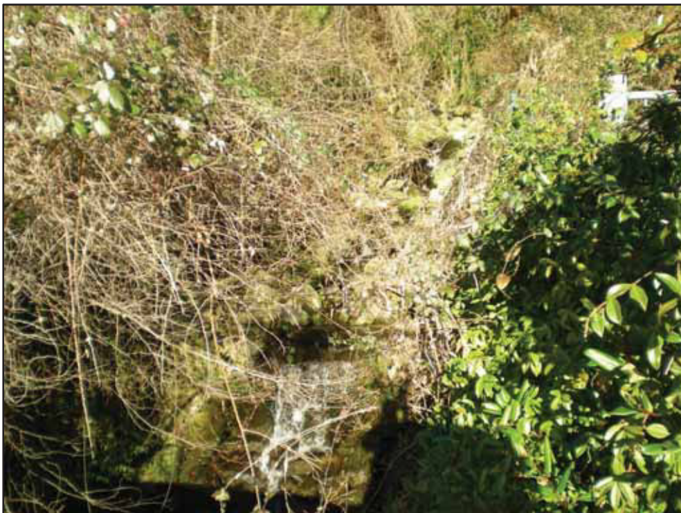
Figura 5 - Tratto superiore del rio che, attraverso una canalizzazione, scorre al di sotto della SP37 in comune di Massino Visconti.
