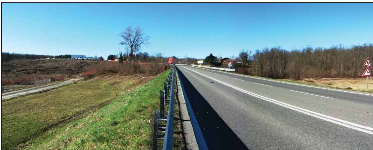
Figura 50 – Tratto della SP142 che scorre in rilevato rispetto al piano campagna in località Borgo Agnello (Posizione B in Figura 29).
