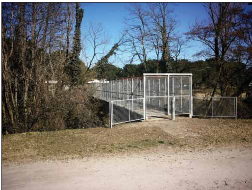
Figura 259 – Passerella ad uso ciclopedonale per il superamento della Roggia Mora nel contesto agricolo di Sizzano, attualmente non fruibile.
