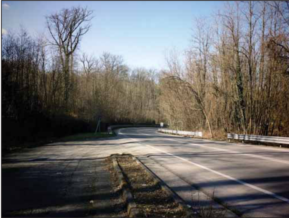
Figura 55 – Tratto superiore della SP142 verso Oleggio Castello che presenta barriere di delimitazione delle proprietà e muri di contenimento che impediscono il passaggio della fauna.
