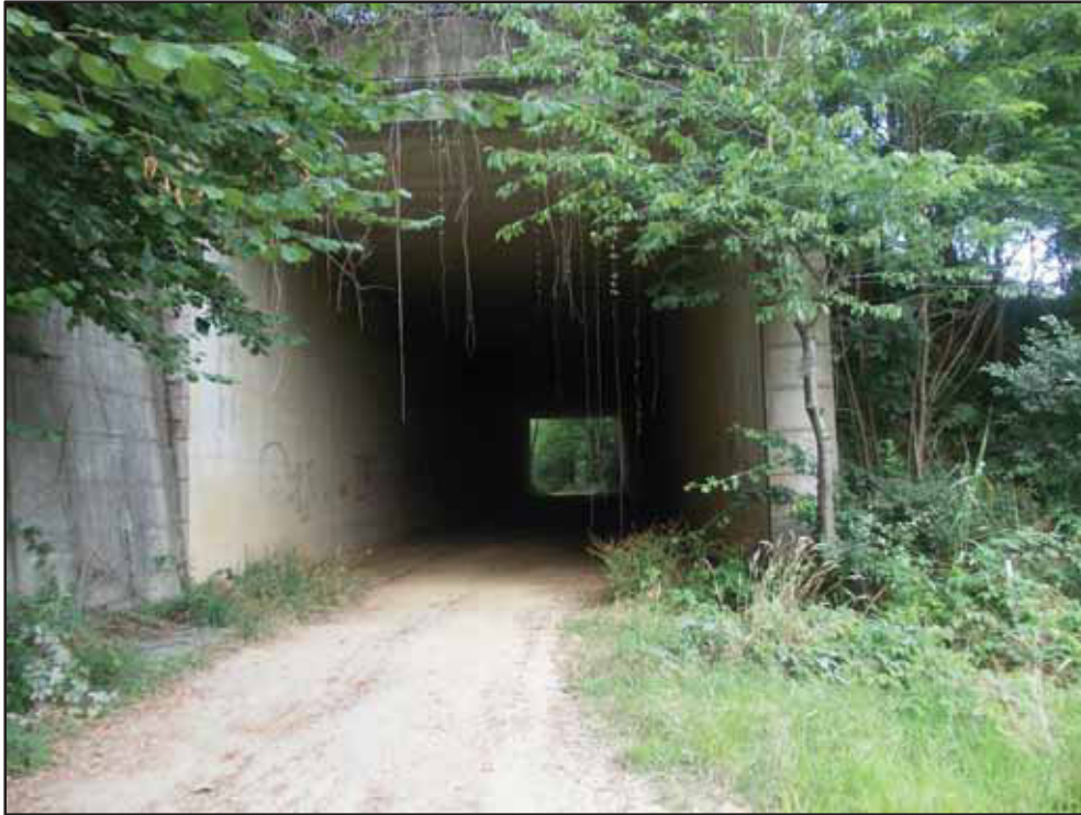
Figura 133 – Dettaglio dell'ingresso al sottopasso dell'autostrada A8/A26 Diramazione Gallarate-Gattico.
