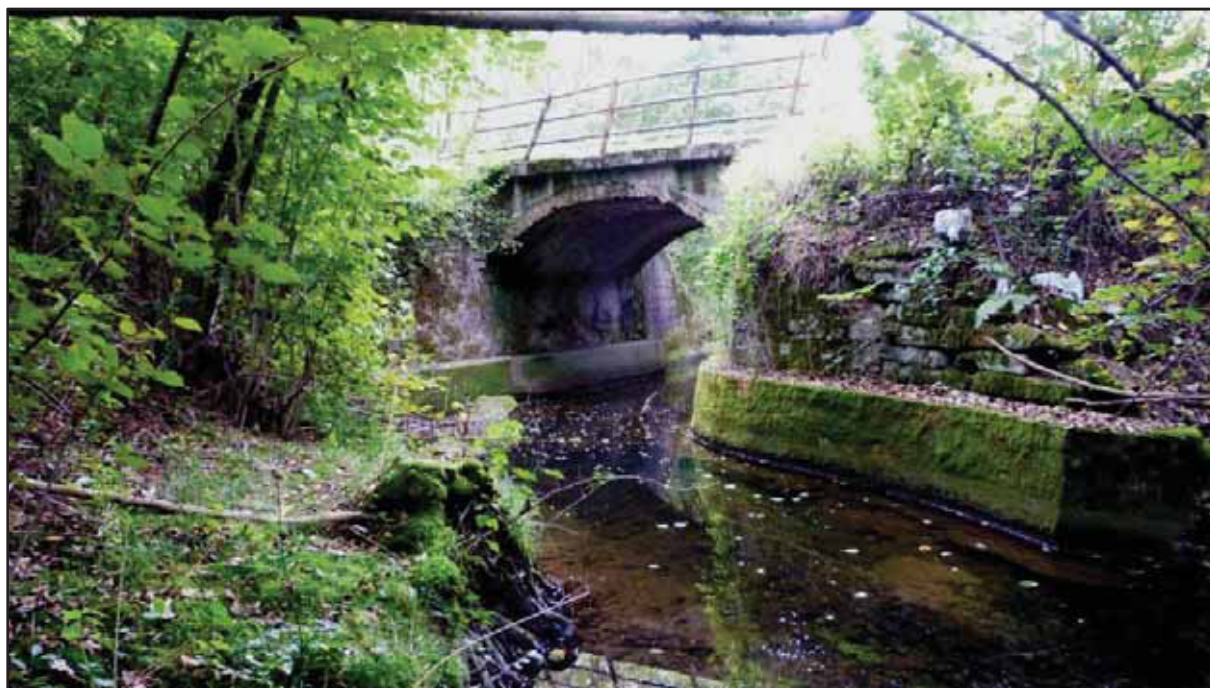
Figura 149 – Struttura della SP84 per il superamento del tratto del torrente Lirene.
