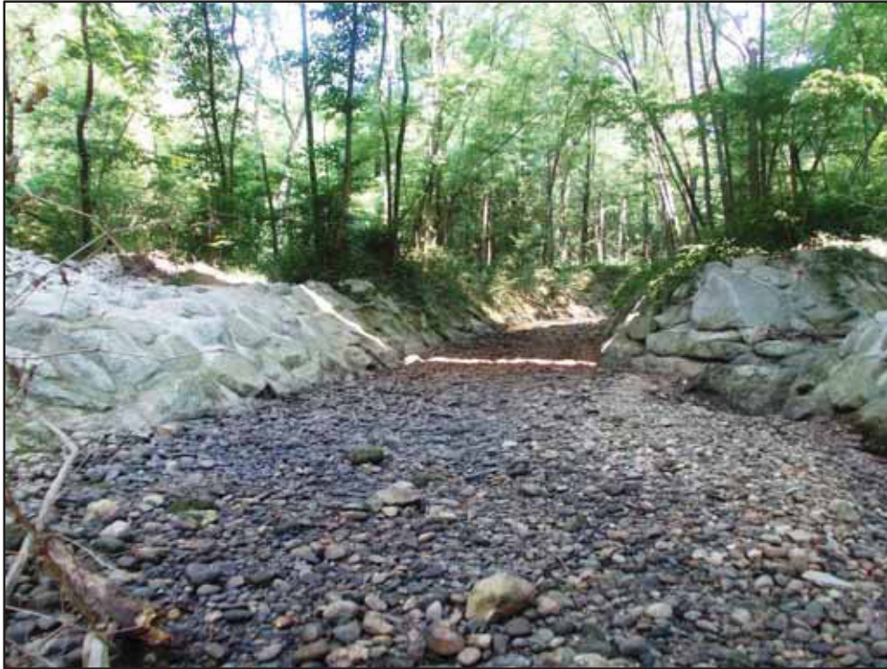
Figura 121 – Alveo incanalato del torrente Lirone nei pressi del varco V18-Borgomanero/Cressa.
