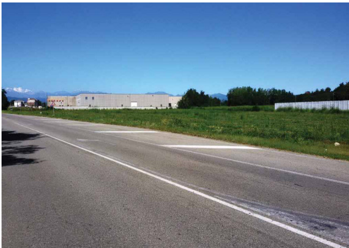
Figura 164 – Tratto della SP229 del Lago d'Orta in direzione di Suno (corsia direzione nord).
