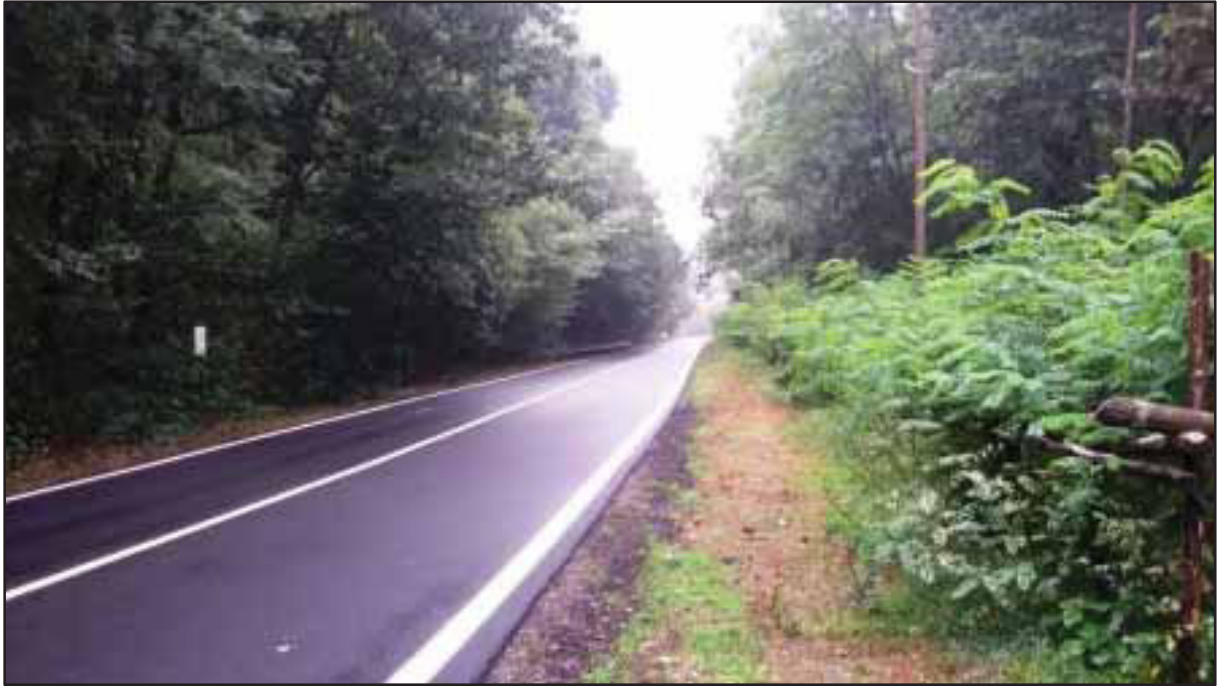
Figura 104 – Tratto meridionale della SP33/A di Briga che attraversa le formazioni boschive presenti nella porzione iniziale del Corridoio C2 (ramo C2b).
