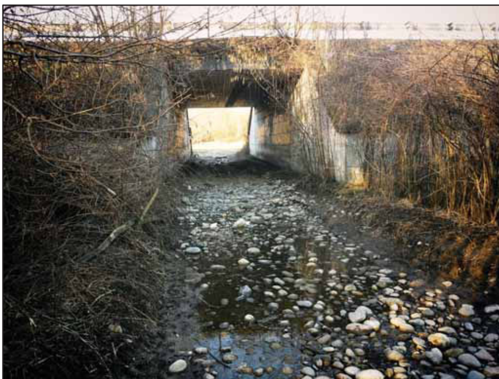
Figura 198 – Ampio sottopasso che consente di superare la tratta dell'accesso autostradale A8/A26 presso Castelletto Ticino.
