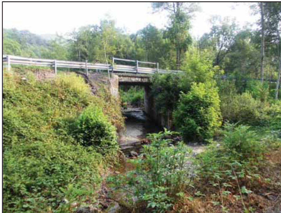
Figura 63 – Tratto incanalato del torrente Terzago sotto il tracciato della SP34 dell'Alto Vergante in territorio comunale di Invorio.
