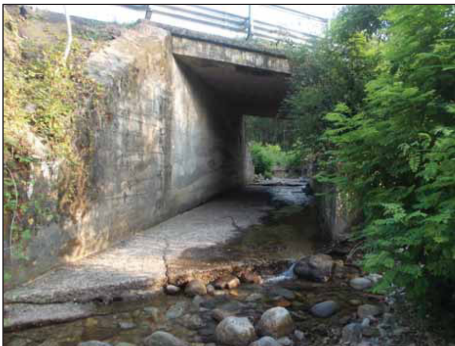
Figura 64 – Particolare dell'uscita a sud del tratto incanalato del torrente Terzago.
