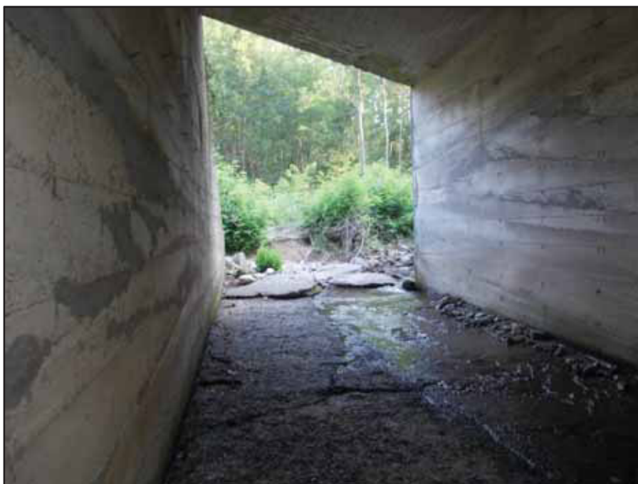
Figura 65 – Particolare dell'ingresso a nord del tratto incanalato del torrente Terzago.
