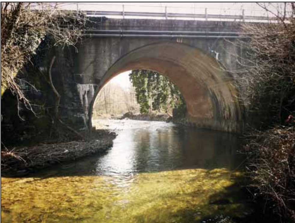
Figura 54 – Ponte della SP142 per permettere il superamento del torrente Vevera.
