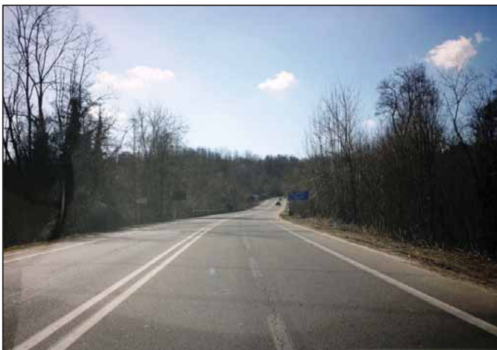
Figura 52 – Tratto della SP142 che precede il ponte sul torrente Vevera.
