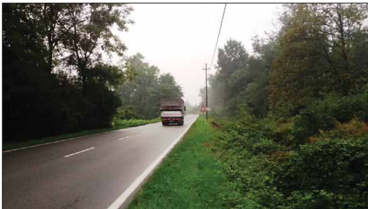
Figura 140 – Tratto della SP19 Castelletto di Momo - Oleggio Castello tra gli abitati di Gattico e Veruno.
