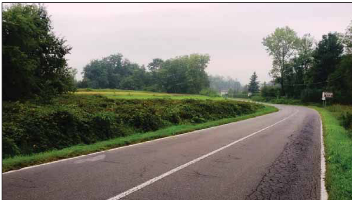
Figura 138 – Tratto meridionale della SP23 Fontaneto/Cressa/Divignano che attraversa il mosaico di colture agricole e formazioni boschive presenti nell'area di connessione tra i corridoi C4a e C4b.
