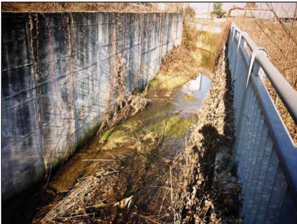
Figura 79 – Tratto del fosso Geola a valle del superamento della SR142 Biellese con argini cementificati ma presenza di depositi e vegetazione terrestre pioniera in alveo.
