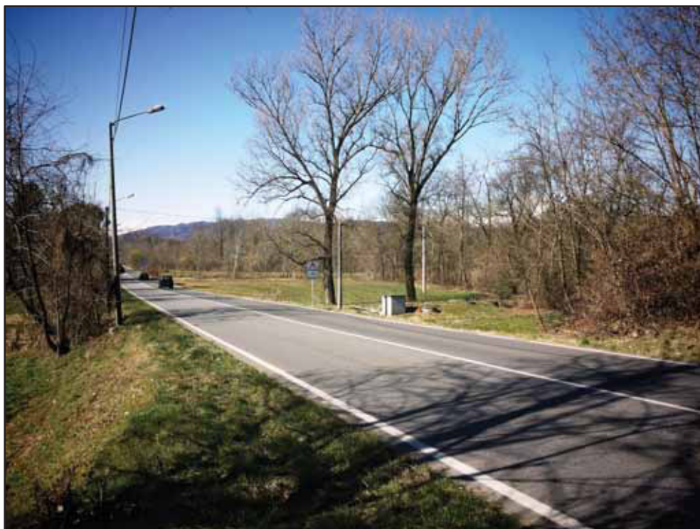
Figura 81 – Tratto della SP32dir. di collegamento tra Borgomanero e Maggiate inferiore, nella porzione meridionale del varco V10-Borgomanero/Gattico.
